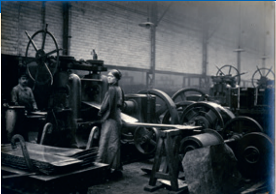
Un atelier de laminage de l'usine des Tréfileries et Laminoirs du Havre. AMH 33Fi40.
