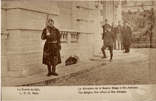
Le ministère de la guerre belge à Sainte-Adresse. Des officiels belges et des militaires sur le parvis du bâtiment du Nice-Havrais. Carte postale. AMH 4Fi915.
