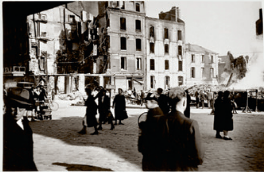
Les gravats du magasin Le Printemps et le magasin Monoprix incendié, rue Thiers, 16 septembre 1941. Photographie anonyme. Don Véronique Eudes, 2014. AMH 54Fi3
