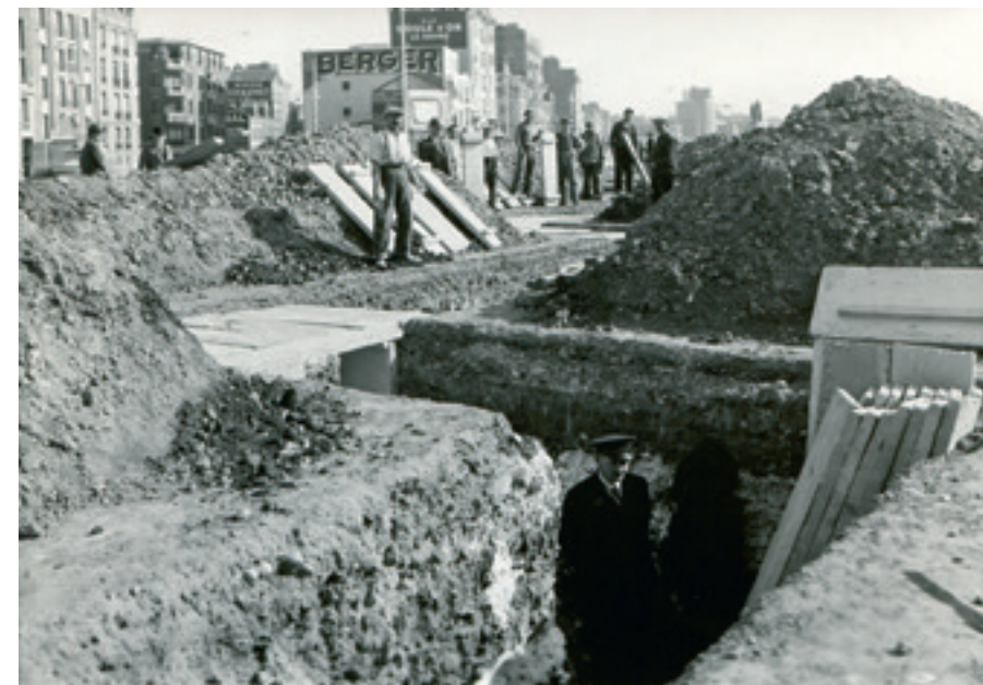
Constructions de tranchées abris, boulevard Albert-1er, 1939-1940. Photographie anonyme. AMH 31Fi2389
